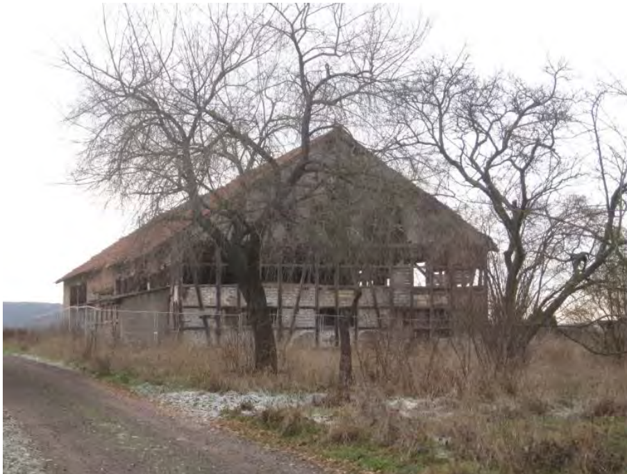
Abb. 14: Entsiegelung durch Abbruch der baufälligen Scheune in der Gemarkung Großrettbach
