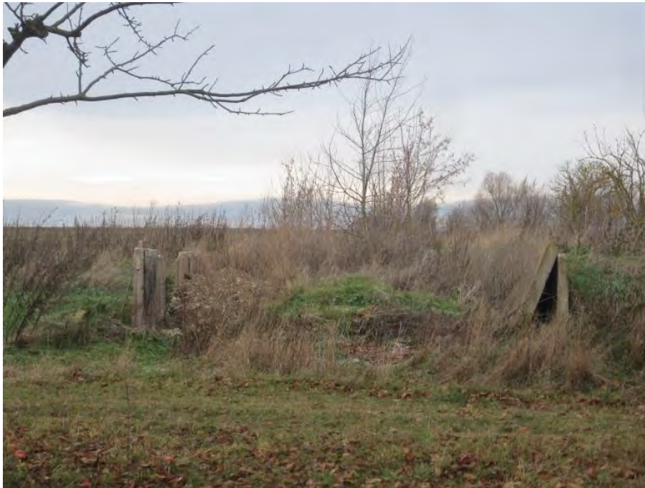
Abb. 15: Entsiegelung durch Abbruch der devastierten Fahrsilo-Anlage
