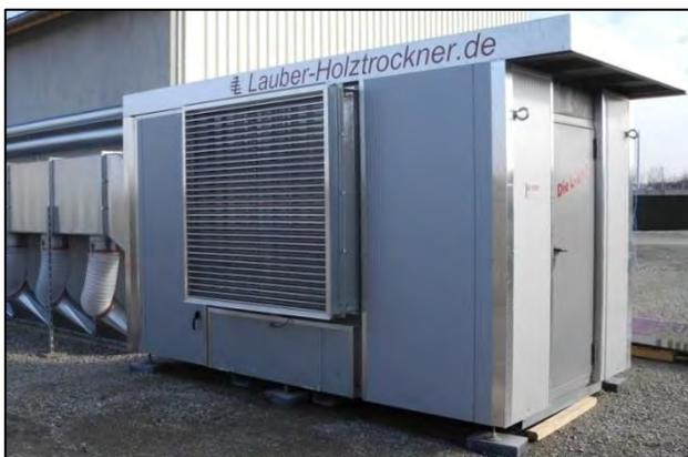
Bild: Luftansaugung einer L-ENZ 370
