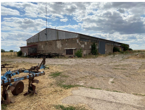
Abb. 7: südliches Gebäude Ri. S, Flächenversiegelung
