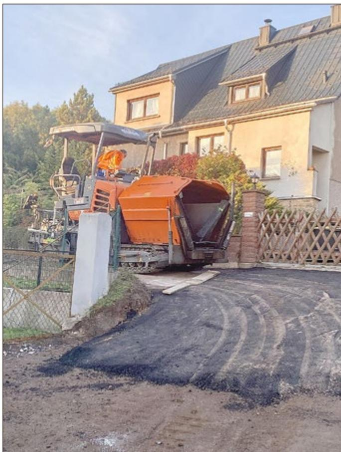
Nun konnten wir durch das Aufbringen einer bituminösen Deckschicht und gepflasterten Querrinnen die Zufahrt wieder gewährleisten und das anfallende Regenwasser gezielt in die Entwässerung führen.
