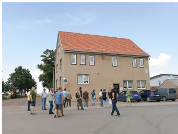
Hier konnte in diesem Jahr, durch Fördermittel, das Dach saniert werden. Im OT Grabsleben wurde sich das Gemeindezentrum mit Turnhalle angeschaut. Dieser Komplex wurde in den 2010er Jahren grundlegend saniert.
