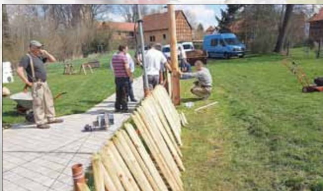
OT Cobstädt: Zaunerneuerung am Feuerwehrvereinsheim
