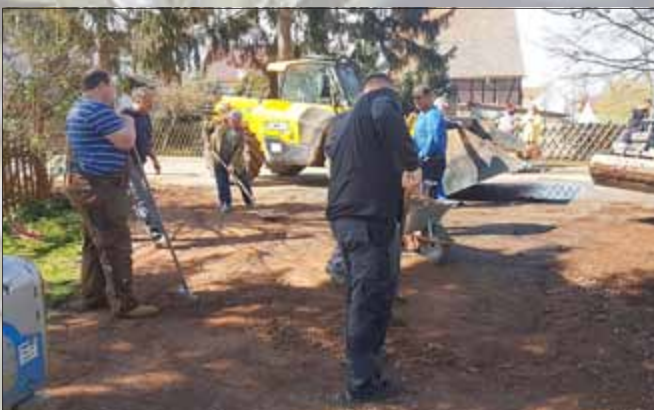
OT Großbrettbach: Arbeiten am Weg zur Geflügelzuchtanlage „Trotz Alledem“
