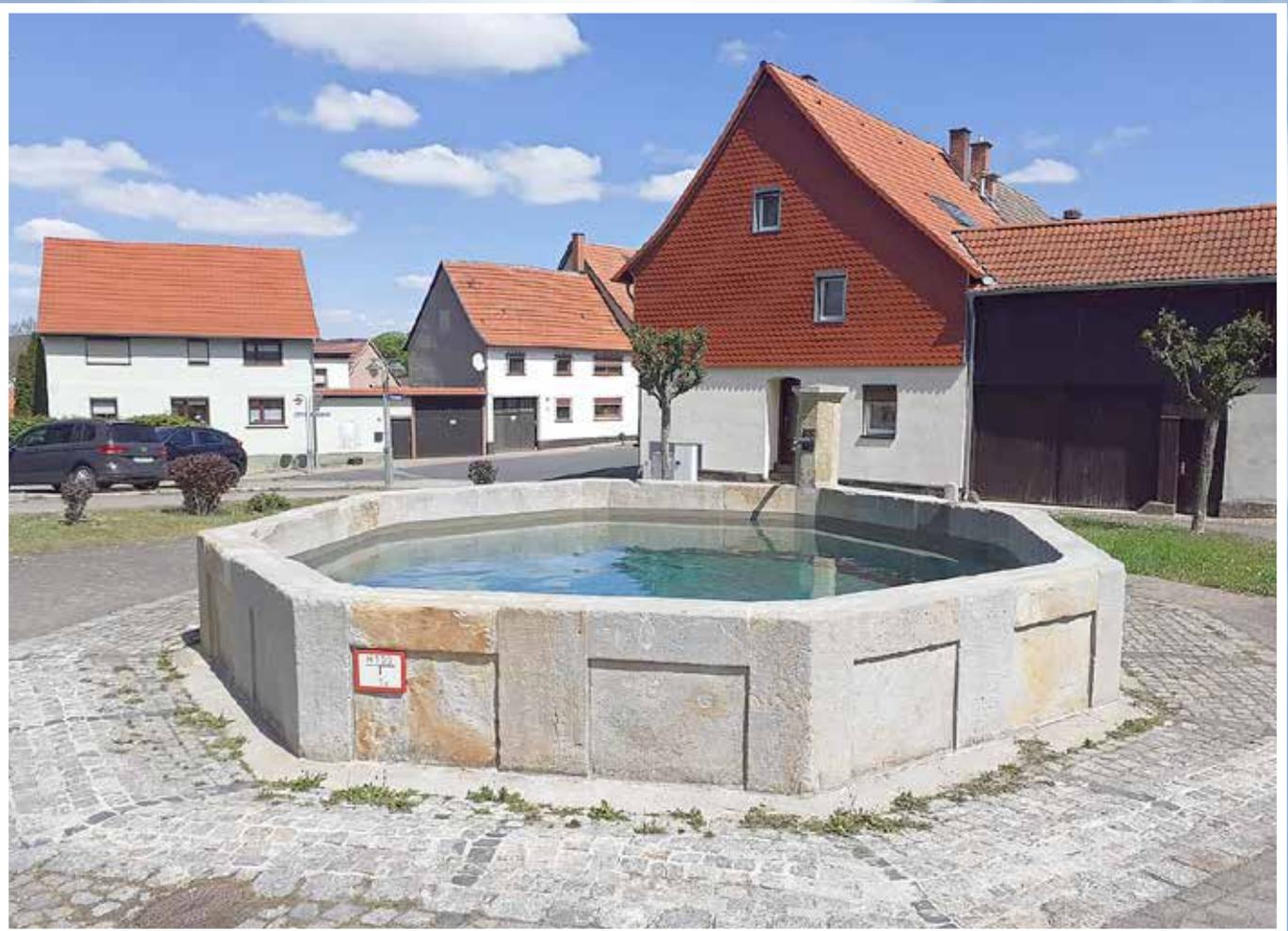
Im Rahmen der Dorferneuerung begann diese Baumaßnahme im Jahr 2019 und wurde nunmehr fertiggestellt. Der Kirchbrunnen wurde im Innenbereich neu abgedichtet und die historischen Sandsteine wurden aufgearbeitet. Weiterhin wurde die Pumpentechnik für die Wasserversorgung des Brunnens neu installiert. Somit konnte die erste Befüllung des Brunnens in der ersten Maiwoche erfolgen.
